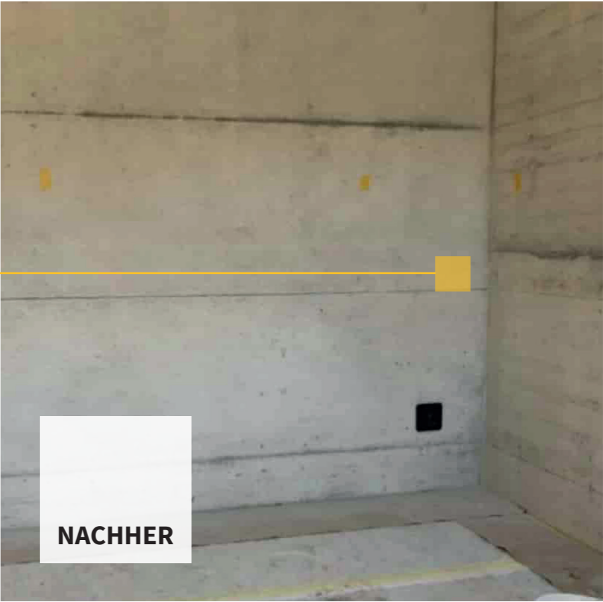
Bindstellen versteckt und Verfärbungen natürlich angeglichen
