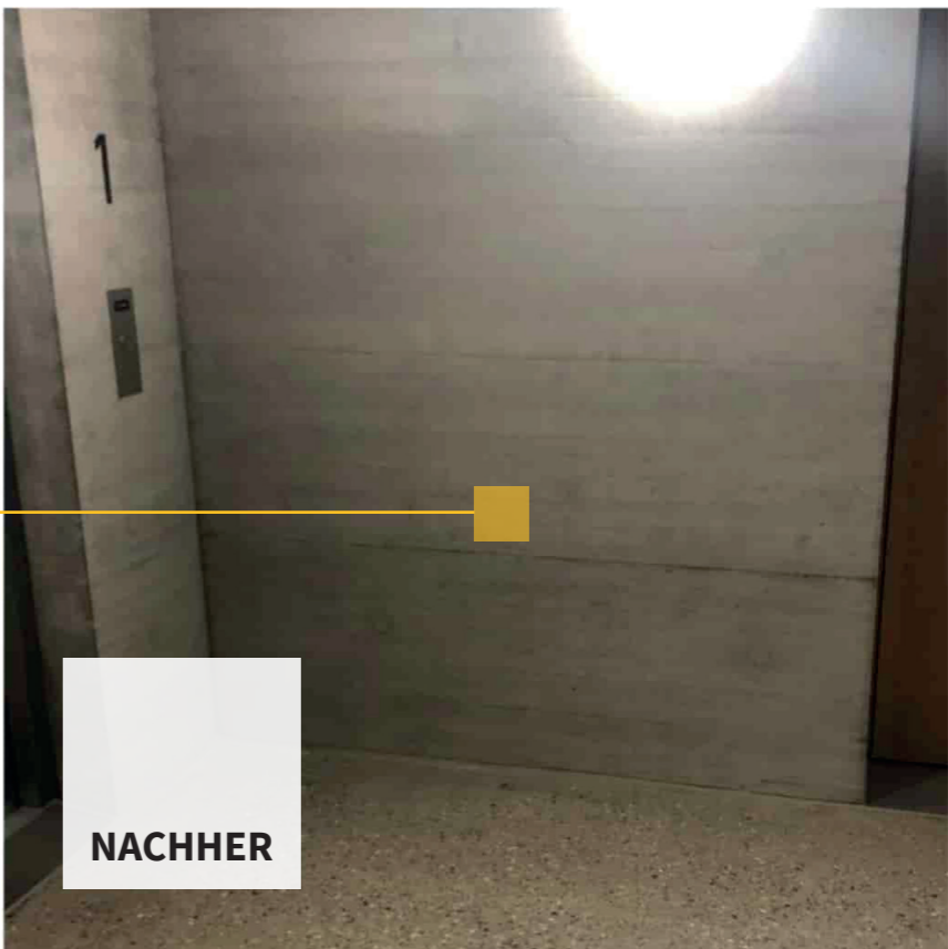
Unschöne Verfärbungen entfernt/angeglichen und Bindstellen an Betonfarbe angepasst
