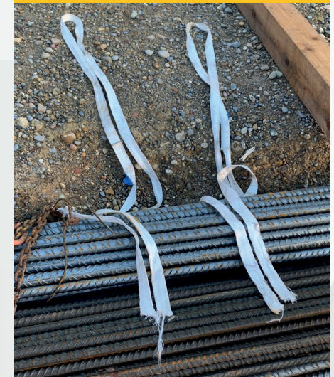
Beim Unfall verwendete Einweg-Hebebänder
