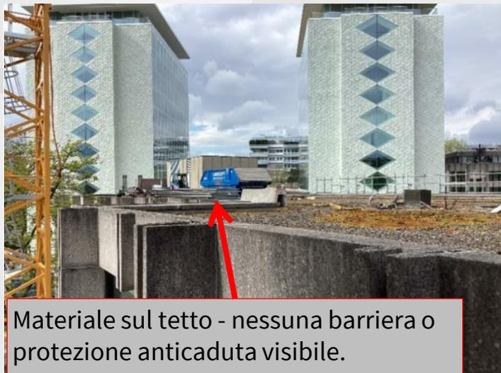
Materiale sul tetto - nessuna barriera o protezione anticaduta visibile.
