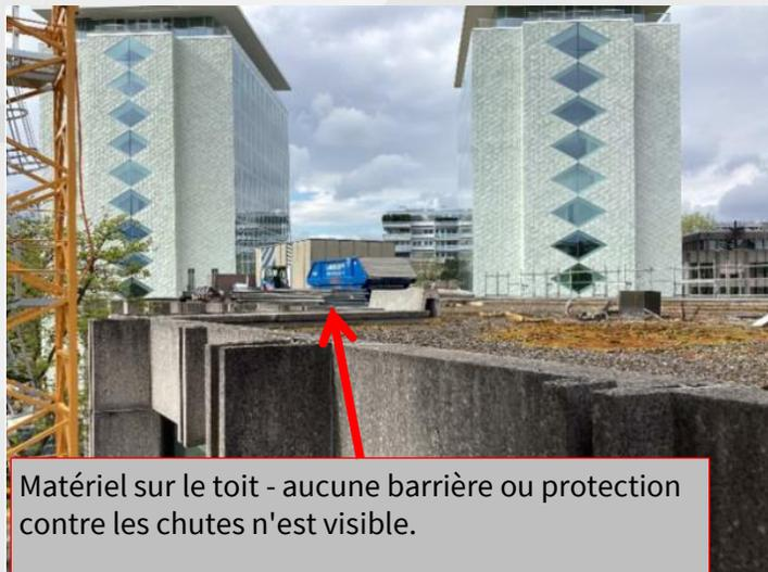
Matériel sur le toit - aucune barrière ou protection contre les chutes n'est visible.
