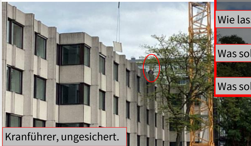
Material auf Dach – Keine Absperrung oder Absturzsicherung zu sehen.
