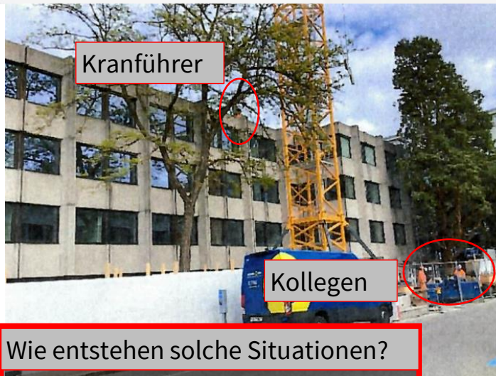
Arbeiter z.T. auf der Schalung stehend bei 3.5 m Absturzkante.
