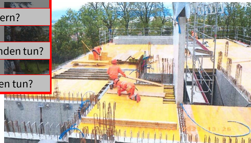
Arbeiter z.T. auf der Schalung stehend bei 3.5 m Absturzkante.
