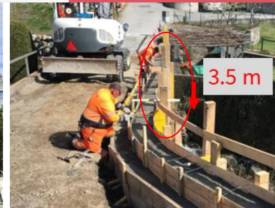
Arbeiter z.T. auf der Schalung stehend bei 3.5 m Absturzkante.
