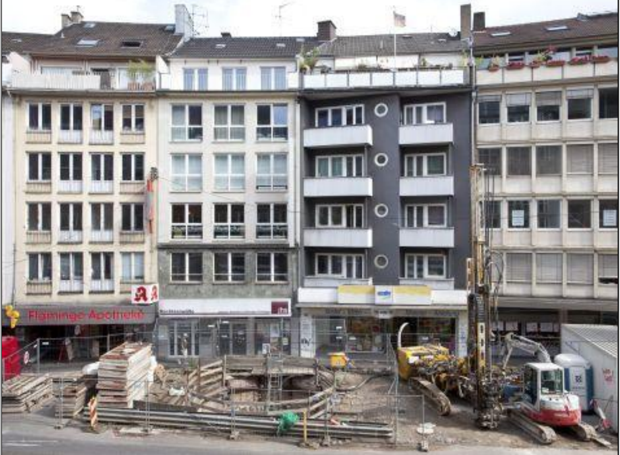
1 Kompensationsschacht am Straßenrand
