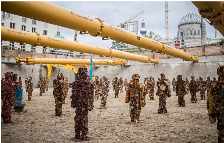
„Trash People“ vom Kölner Aktionskünstler HA Schult in der fertiggestellten Baugrube
