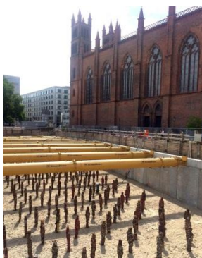
Blick in die Baugrube in Richtung Süden
