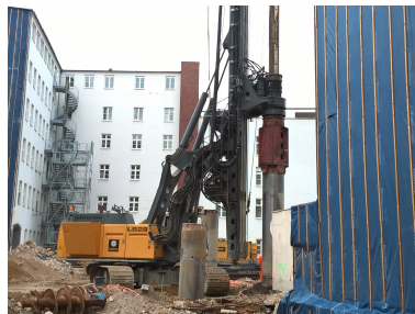
Bohrpfahlerstellung
