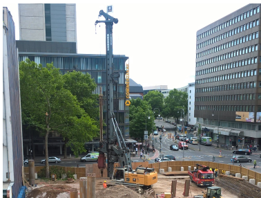
Blick auf die Baugrube
