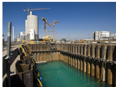
Spundwandbaugrube mit UW Betonsohle
