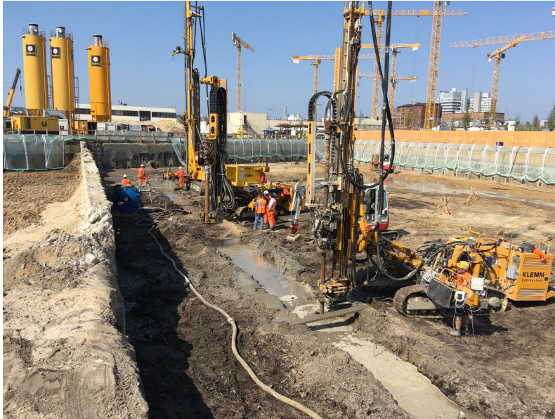
Düsenstrahlarbeiten in Blickrichtung Norden
