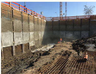
Spritzbetonarbeiten
