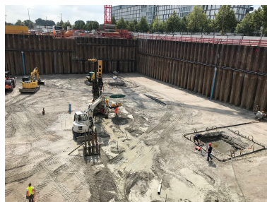
Herstellung der Auftriebssicherung
