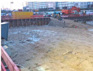
Herstellung der Weichgelsohle
