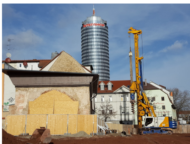
Bohrpfahlarbeiten
