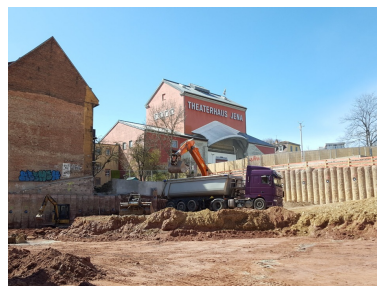
Tangierende Bohrpfahlwand
