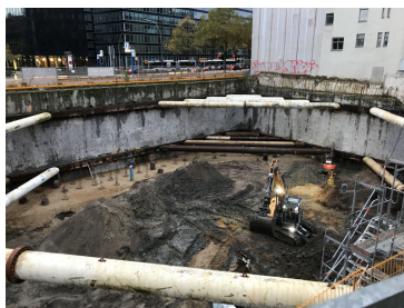
Baugrubenendaushub nach Einbau der 2. Aussteifungslage
