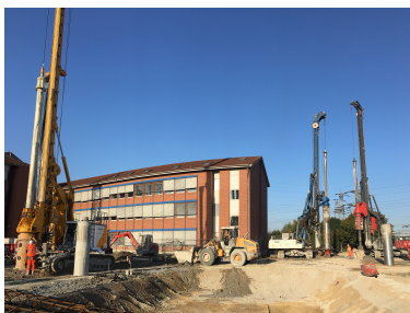
Herstellung der Pfahlwand
