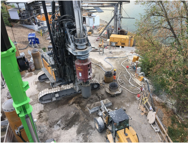
Pfahlarbeiten am Zielschacht
