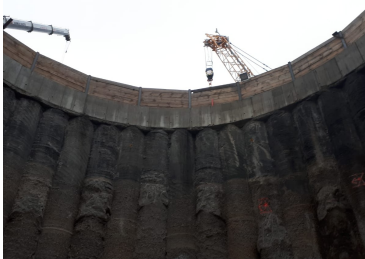
Überschnittene Pfahlwand Startschacht
