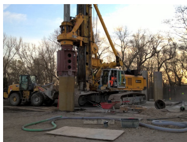
Pfahlarbeiten am Startschacht
