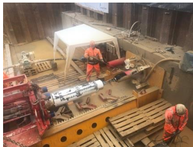
Einzug PE Leitung in aufgeföhrene Trasse
