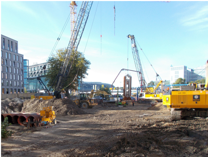
Baufeld während der Schlitzwandherstellung und Trassenberäumung
