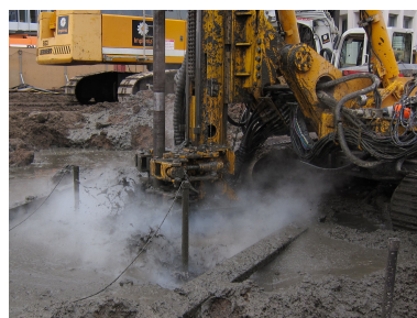
Herstellung der DSV-Probensäulen mit Reichweitenmessung zur Durchmesserbestimmung
