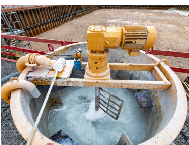
Rührbehälter mit Injektionsgut
