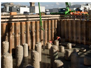
UW Betonage
