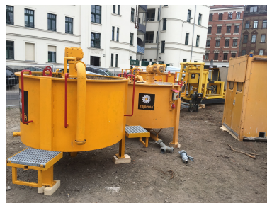
Baustelleneinrichtung, Mischbehälter
