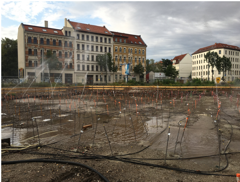
Baufeld mit Injektionsröhrchen
