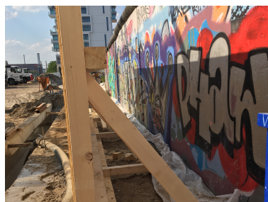
Sicherung der East Side Gallery
