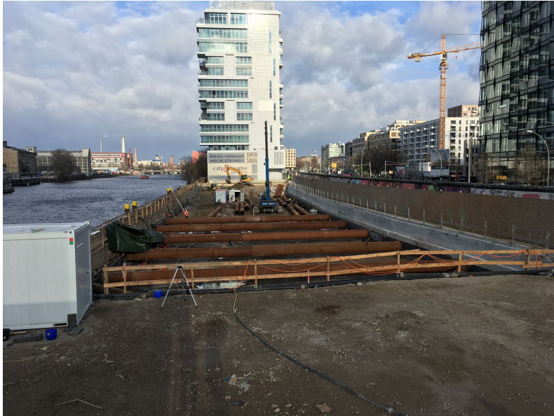
Blick auf die Baustelle: Aussteifung
