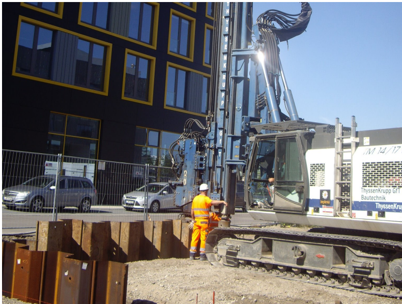
Herstellung der Spundwand
