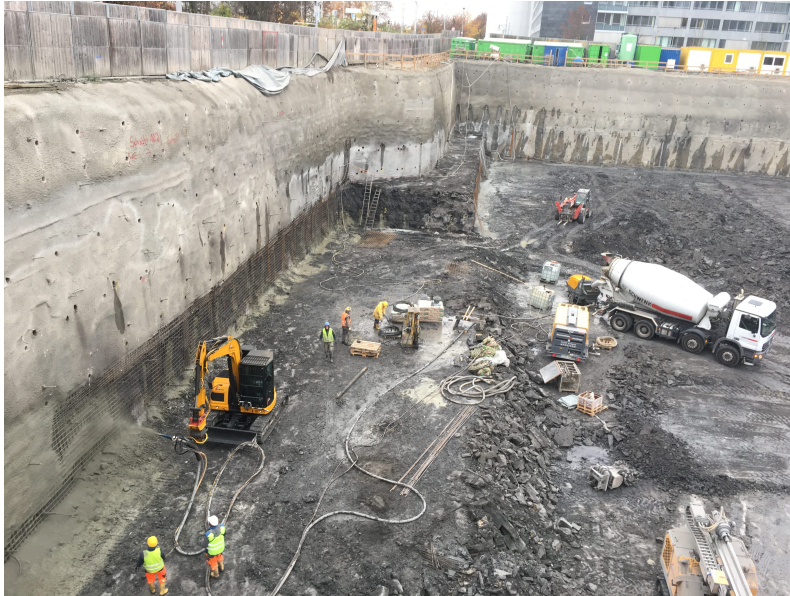
Herstellung vernagelte Spritzbetonwand
