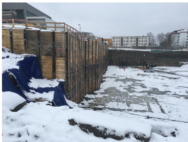
Holzverbau und Spritzbetonwand
