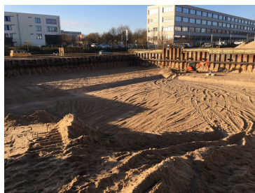
Baufeld mit Aushubarbeiten
