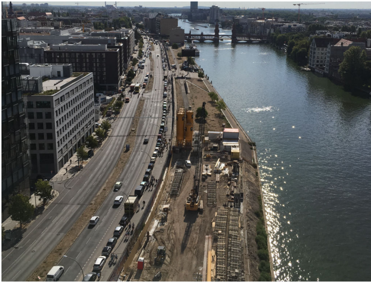
Blick auf die Baustelle
