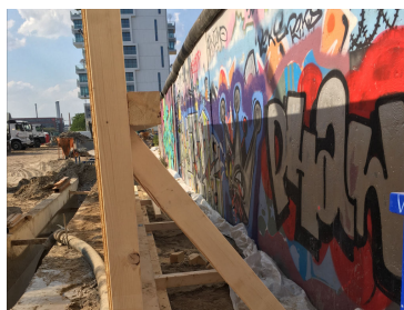
Sicherung der "East Side Gallery"
